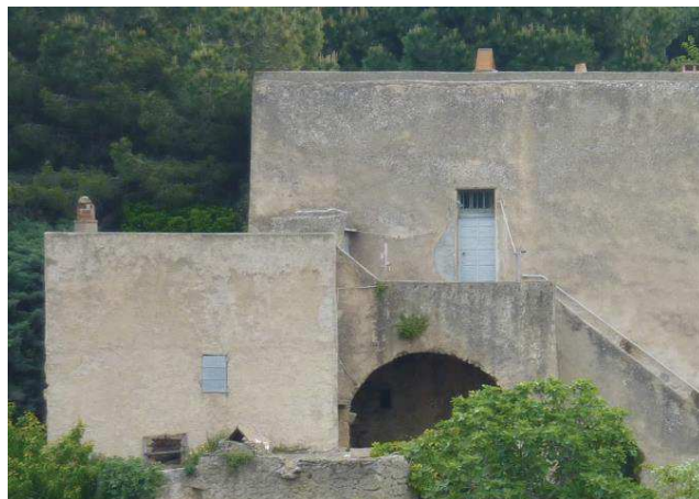
Perron sur voûte
