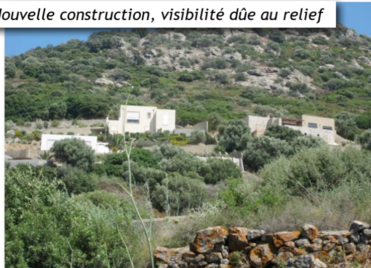
Une végétation dense dissimule les constructions
