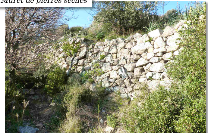
Muret de pierres sèches
