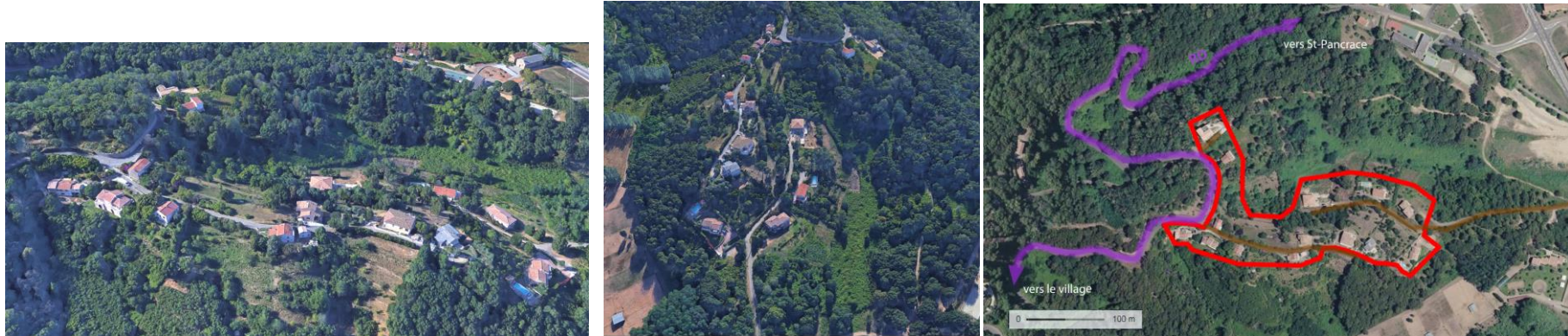
Enveloppe bâtie du secteur de Costa
