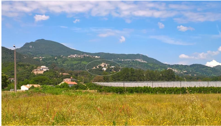
G. Vue depuis l'ancienne voie de chemin de fer en plaine
