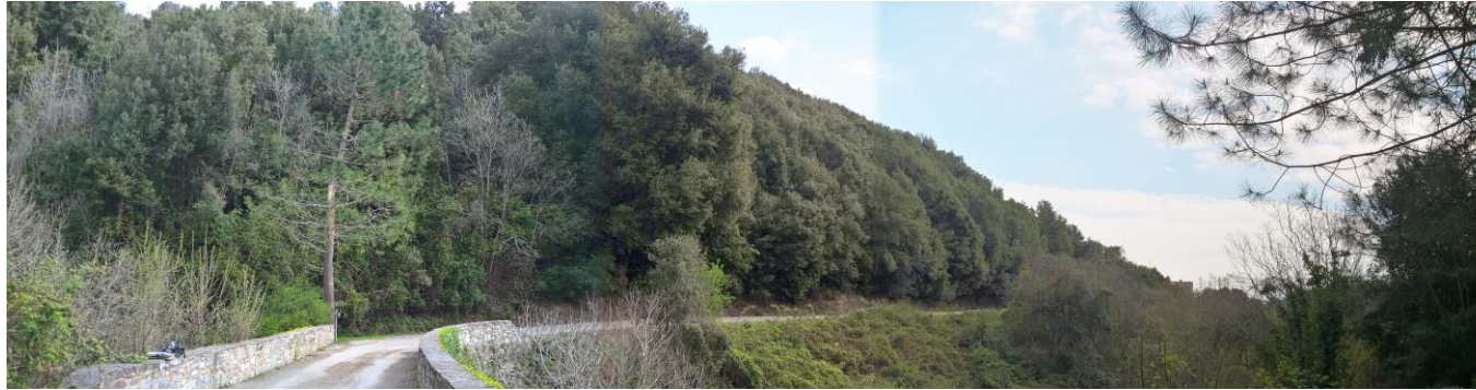
sud-ouest du village
