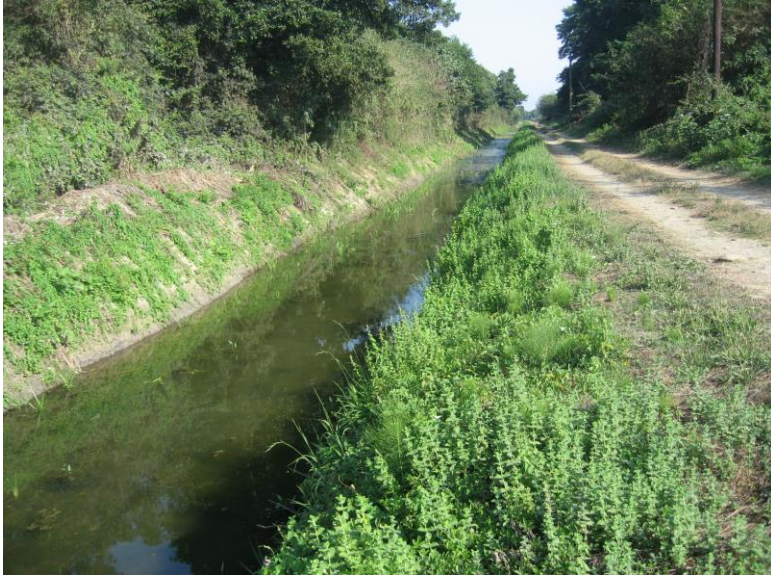
Le canal central qui longe la limite ouest du village d'Anghione
