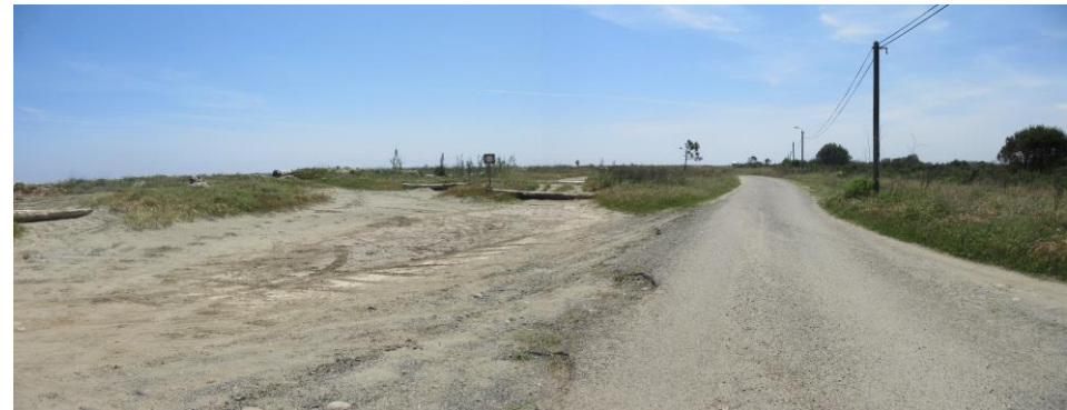
Route et pistes partant du parking goudronné vers la limite sud de la commune
