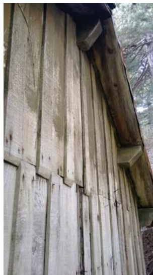
Bardage avec couvre joint / Photo GTB
