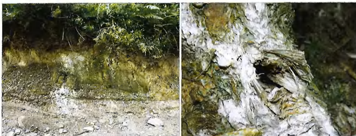
Illustration 69 : Vue générale du site 2BFC193 et aspect des structures amiantifères.
