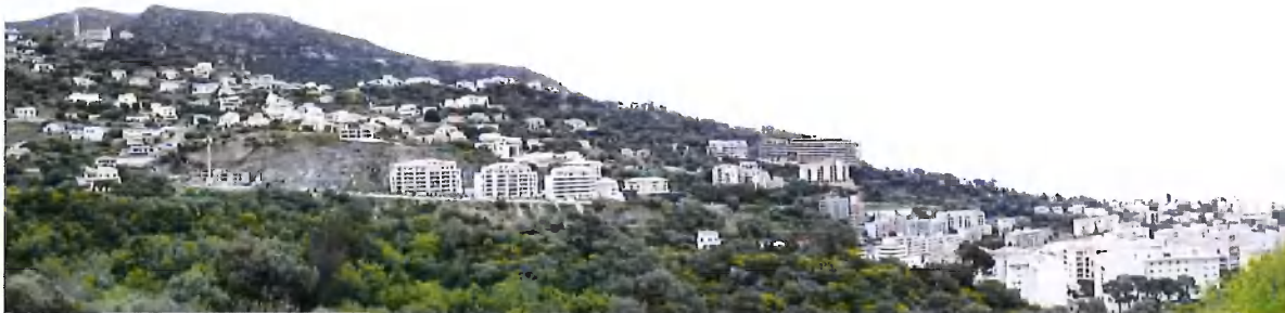
Illustration 187 : Vue générale du quartier construit sur des serpentinites amiantifères.
