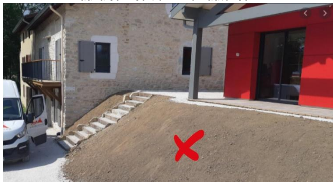
Mauvaise insertion - Non autorisé
