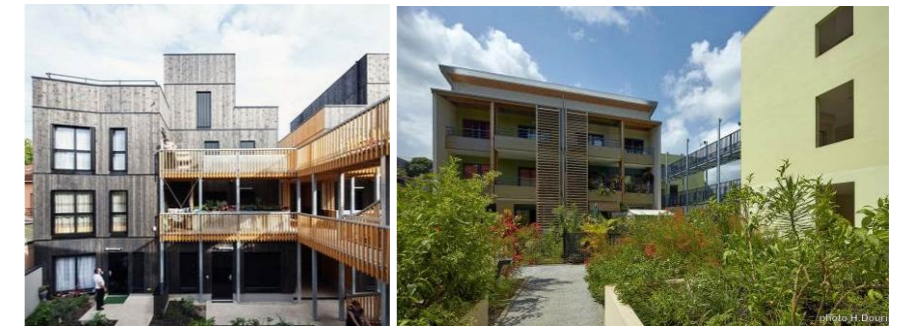
Exemples de bâtiments avec coursive extérieure
