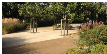
< Exemple de sol drainant stabilisé
