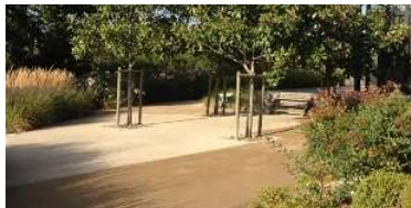
< Exemple de sol, drainant stabilisé
