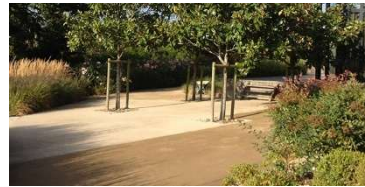
< Exemple de sol drainant stabilisé
