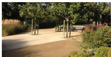
< Exemple de sol drainant stabilisé
