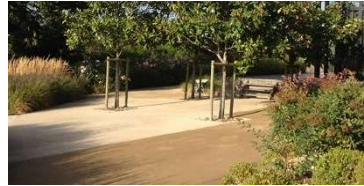
< Exemple de sol drainant stabilisé
