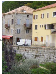
Exemple de murs de soutènement
