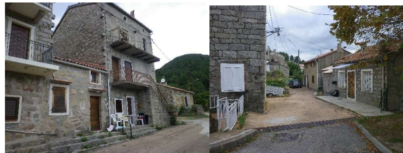
Des perrons face aux rues, des espaces publics intimistes et absence de clôtures.
