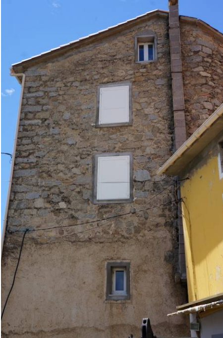
Volets pleins en PVC – encadrement Ciment
