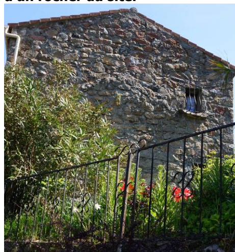
Balustrade et clôture en ferronnerie à la teinte adaptée
