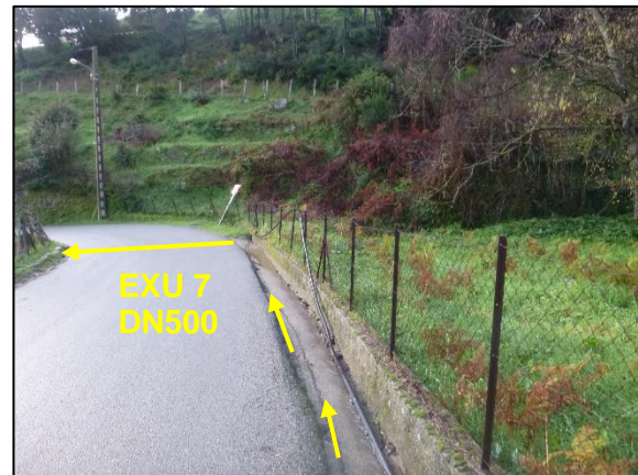
Photo 6 : BV n°7, caniveaux et chemin de grille en bord de RD 161
