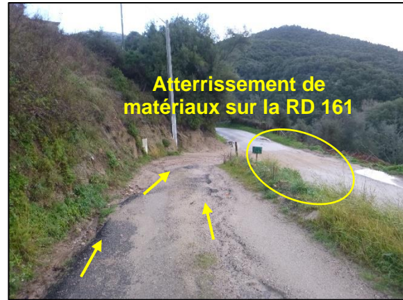
Photo 5 : BV n°6, ravinements sur un accès à une habitation en cours de construction
