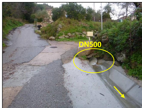
Photo 8 : BV n°7, canal, partie amont
