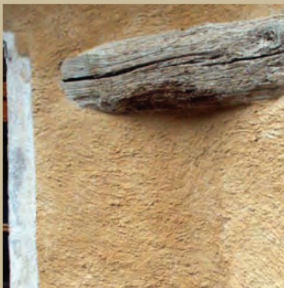
enduit fouetté et chaîne d'angle lissée, réhaussée au badigeon blanc
