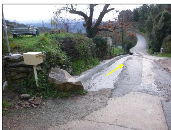
Photo 9 : BV n°7, canal, vue générale
