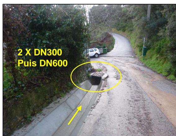
Photo 10 : BV n°7, canal, partie aval
