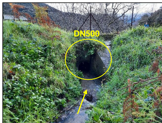
Photo 12 : Exutoire n°7, traversée de RD 161
