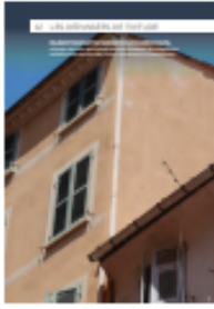
12 les dépassées de toiture
