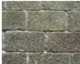
Appareillage régulier en pierre de taille, montés à sec ou à joints fins.
