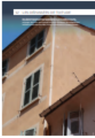
12 les dépassées de toiture
