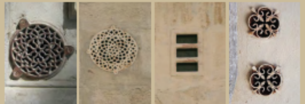
Grilles de ventilation intégrées dans la maçonnerie
