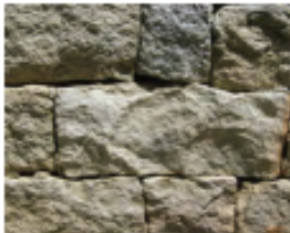
Appareillage régulier en moellons équarris, montés au mortier de chaux.
