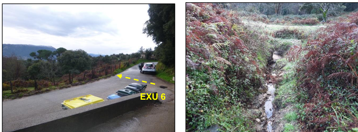
Photo 4 : BV n°6, exutoire (EXU 6) en traversée de RD 161
