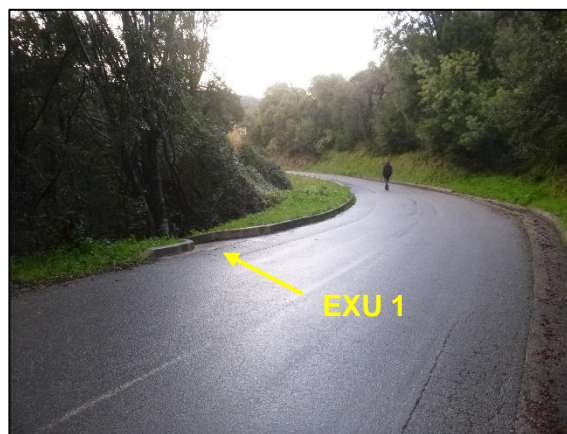
Photo 2 : BV n°1, bordure, caniveau et exutoire (EXU 1)
