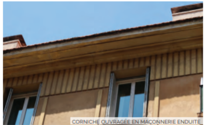
CORNICHE OUVRAGÉE EN MAÇONNERIE ENDUITE
