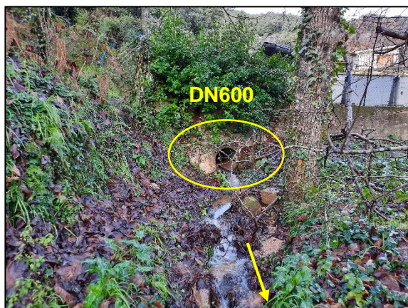
Photo 11 : BV n°7, cours d'eau laissé à ciel ouvert
