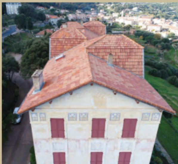
Toiture de l'hôtel des Roches Rouges à Piàna, en tuiles mécaniques de type Huguenot H14
