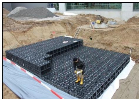
Photo 39 : Mise en place d'un bassin enterré à structure alvéolaire
