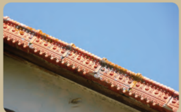
Tuiles de rive en terre cuite ouvragées à Tavera
