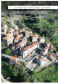
01 la construction dans la pente
