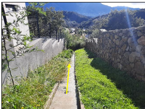
Photo 30 : BV n°20, canal bétonné
