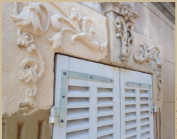
Restauration de décors d'encadrement de fenêtre en ciment moulé
