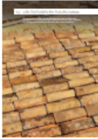
13 les toitures en tuiles canal
