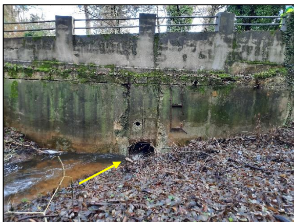
Photo 33 : Ouvrage de traversée du ruisseau de TINTURAGGIO (DN1000) au niveau du hameau de Sarrume (EXU 24 amont/aval)
