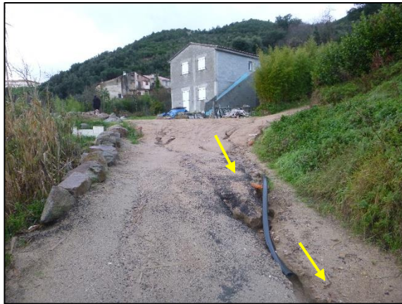
Photo 5 : BV n°6, ravinements sur un accès à une habitation en cours de construction
