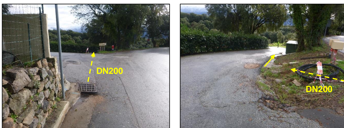
Photo 24 : BV n°13, regard grille et rejet sur la voirie
