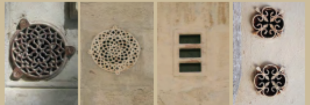
Grilles de ventilation intégrées dans la maçonnerie
