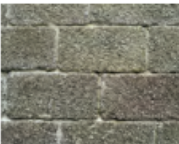
Appareillage régulier en pierre de taille, montées à sec ou à joints fins.
