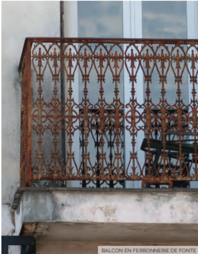
BALCON EN FERRONNERIE DE FONTE
