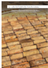
13 les toitures en tuiles canal
