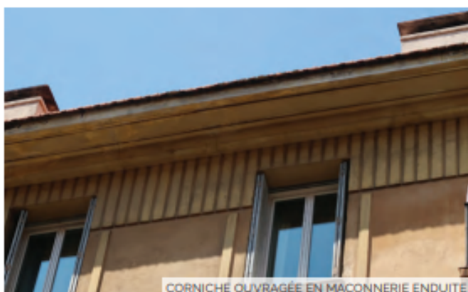
CORNICHE OUVRAGÉE EN MAÇONNERIE ENDUITE
