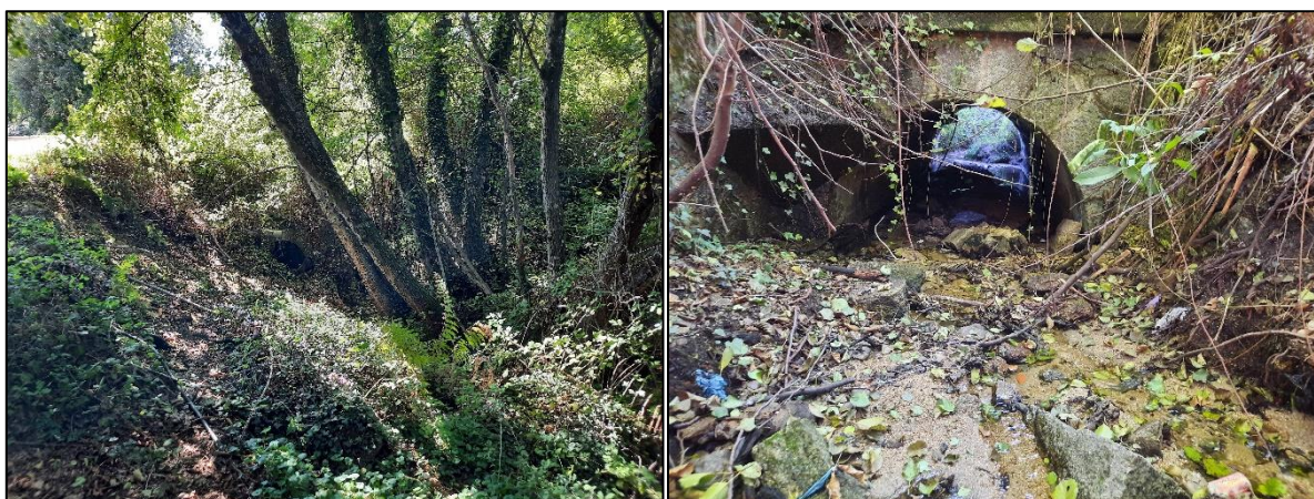
Figure 7: Affluent du ruisseau de l'APA sous la route départementale n°83 (Gauche : AMONT / Droite : AVAL)
