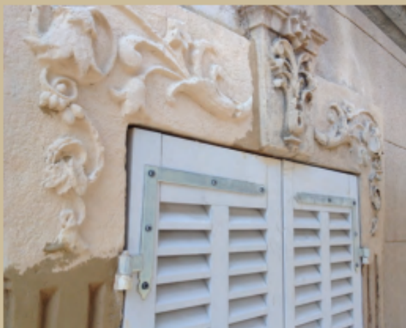
Restauration de décors d'encadrement de fenêtre en ciment moulé
