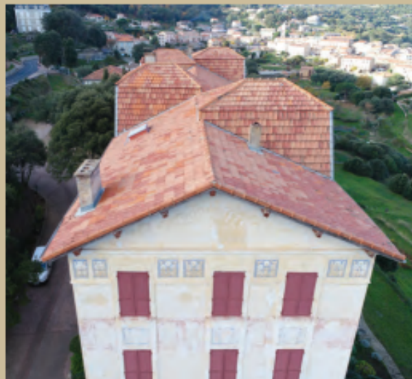
Toiture de l'hôtel des Roches Rouges à Piana, en tuiles mécaniques de type Huguenot H14
