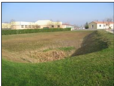
Figure 19: Bassin de rétention en forme de noue
