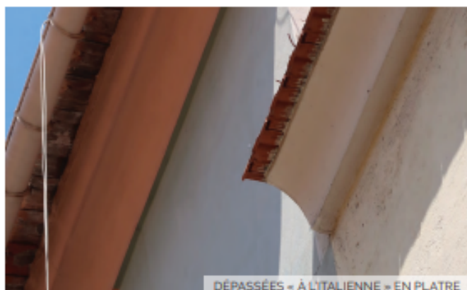
DÉPASSÉES « À L'ITALIENNE » EN PLÂTRE
