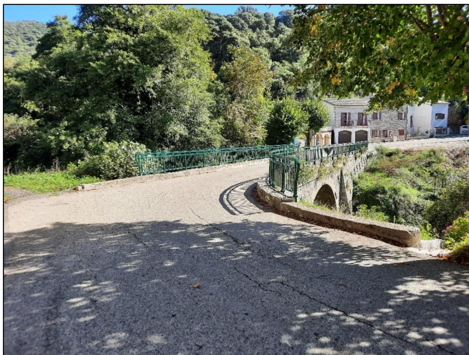
Figure 5: Cours d'eau de la Petra Niella sous la RD n°83
