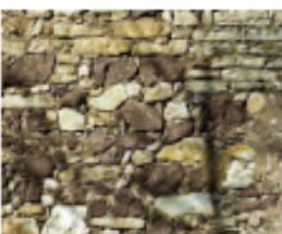
Appareillage de gros et petits moellons non assisés, non équarris et montés au mortier de chaux et sable.
