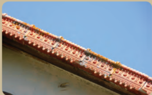
Tuiles de rive en terre cuite ouvragées à Tavera
