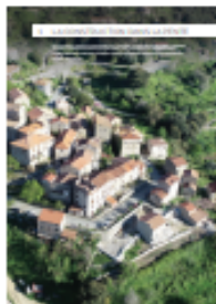
01 la construction dans la pente
