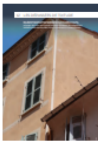
12 les dépassées de toiture
