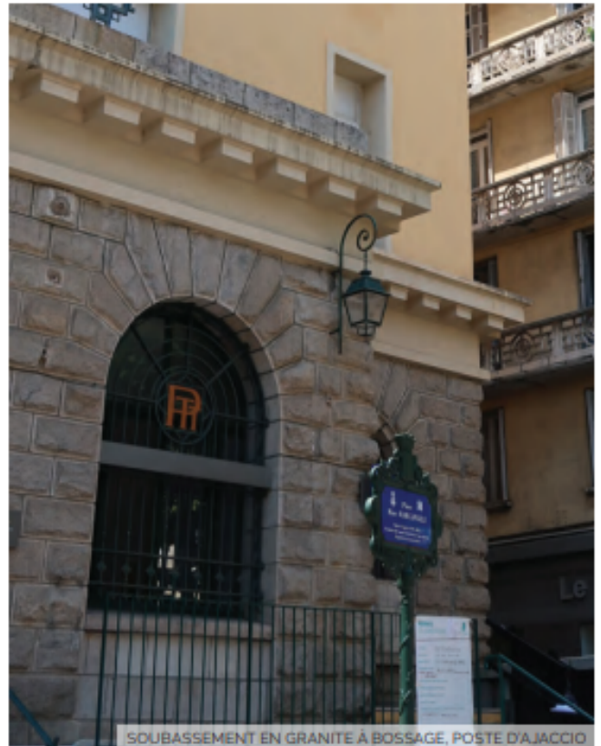
SOUBASSEMENT EN GRANITE À BOSSAGE, POSTE D'AJACCIO
