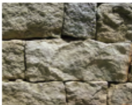
Appareillage régulier en moellons équarris, montés au mortier de chaux.
