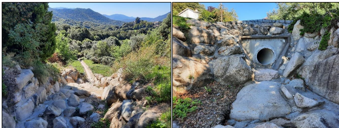
Figure 6: Traversée sous la route départementale n°83
