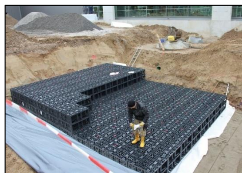
Figure 21: Mise en place d'un bassin enterré à structure alvéolaire
