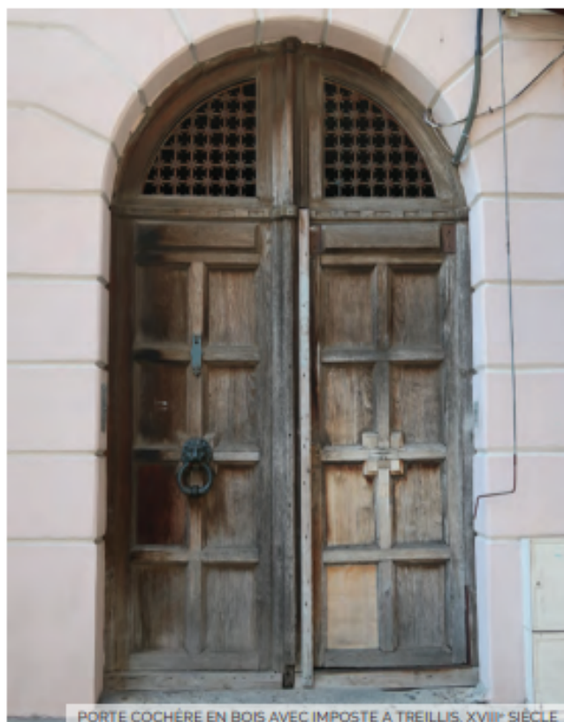
PORTE COCHÈRE EN BOIS AVEC IMPOSTE A TREILLIS, XVIII e SIÈCLE
