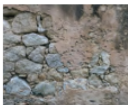
Appareillage de moellons de toute tailles non assisés, équarris ou non et montés au mortier de chaux et sable.
