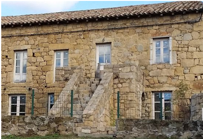
Pluralité des styles de clôtures et de matériaux Grille rigide devant une maison remarquable
