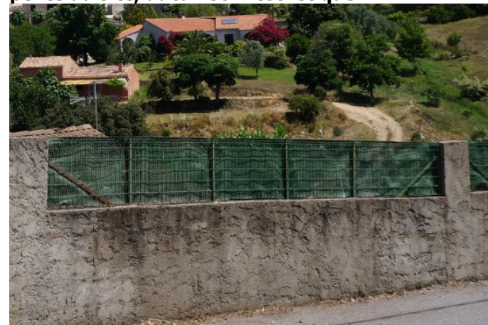
Clôture maçonnée et grillage avec toile : trop haut, créer un effet de couloir vis-à-vis de la route
