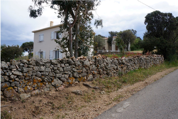
Maintien du muret d'origine -
