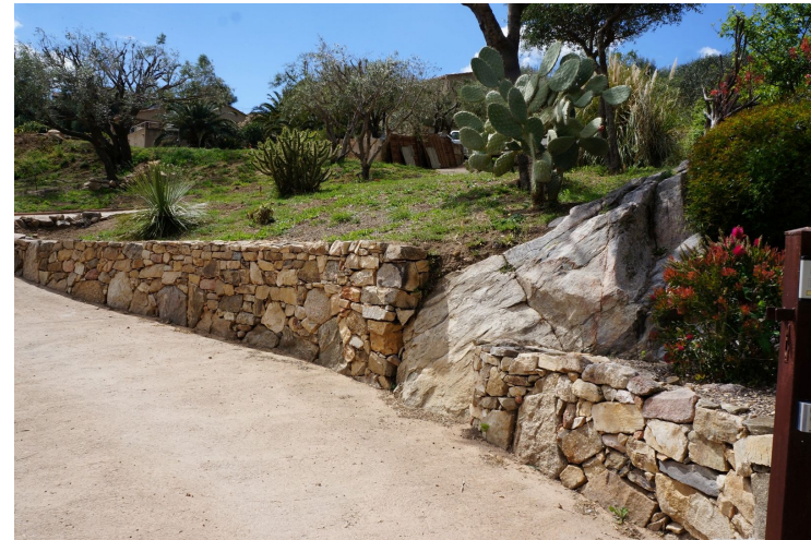
Muret de soutènement en pierres sèches, insertion d'un rocher du site .
