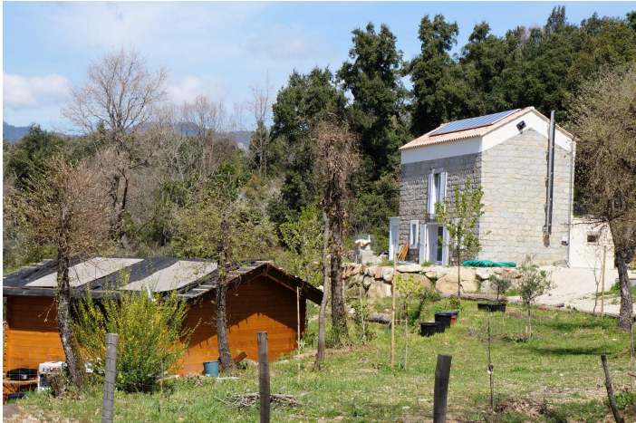
Surélévation d'un bâtiment traditionnel avec des matériaux différents ; annexes en bois clair brillant, enrochement, panneaux solaires trop visibles ; menuiseries PVC.
