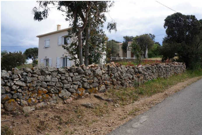
Maintien du muret d'origine -
