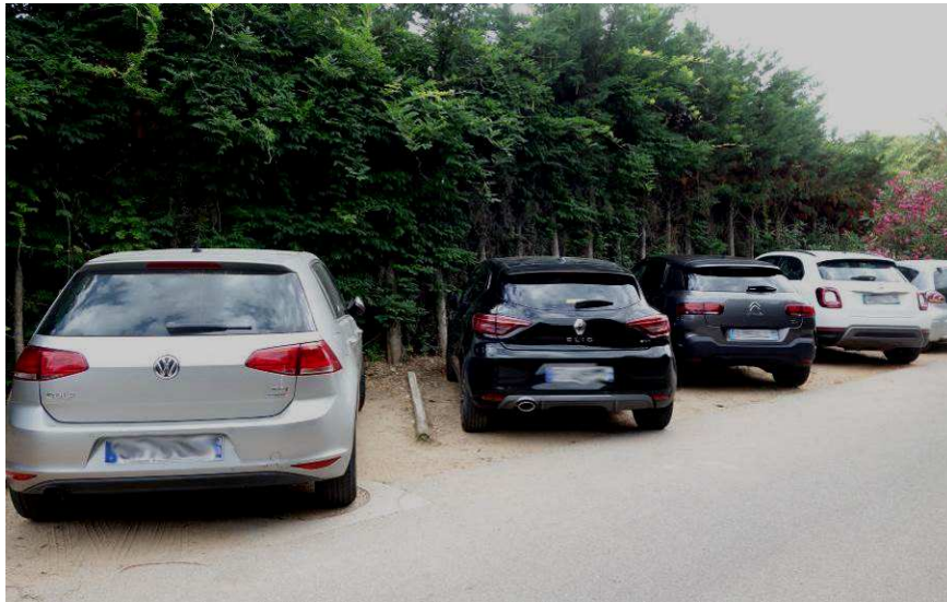
Espace de stationnement perméable avec séparation par des rondins de l'isoella
