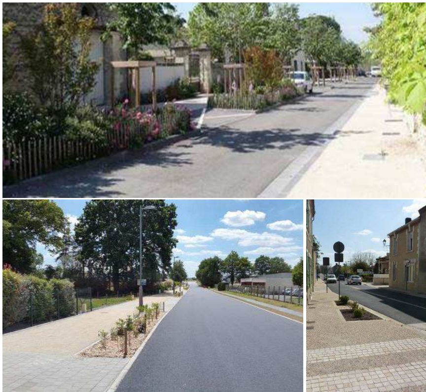
Exemples de différences de traitement de la voirie
