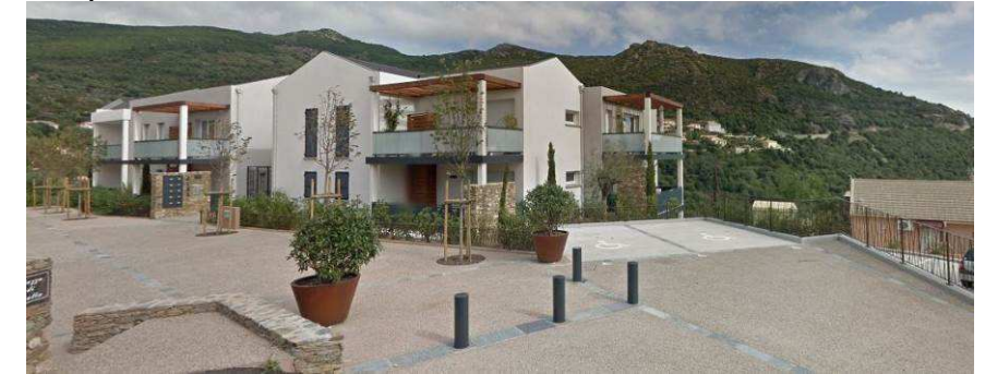
Exemple de logements communaux à Ville-di-Pietrabugno
