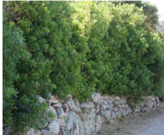
Exemple de murs à préserver
