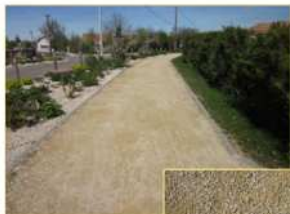
Stabilisé mécaniquement « STABILISÉ CALCAIRE »
