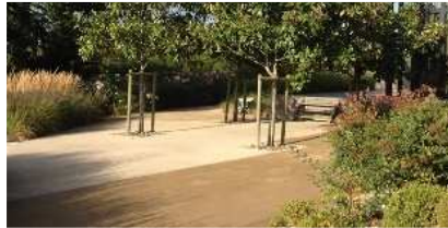
< Exemple de sol, drainant stabilisé
