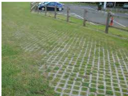
Exemple de sol, drainant stabilisé
