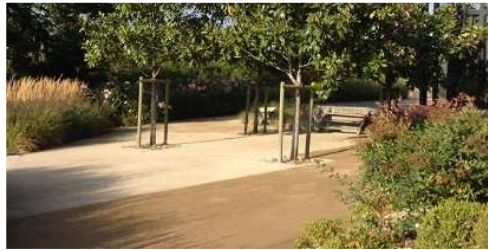
< Exemple de sol, drainant stabilisé
