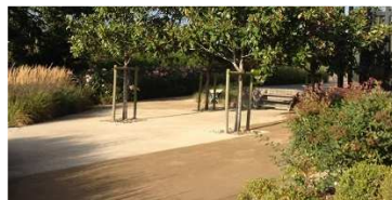
< Exemple de sol drainant stabilisé
