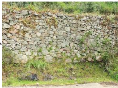
Exemple de murs de soutènement
