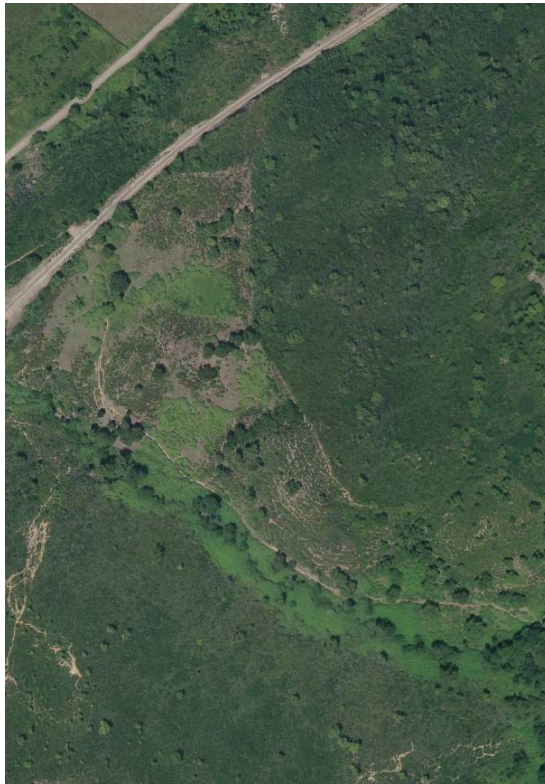
Etat des lieux (photo aérienne 2016)
