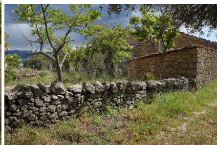
Conservation d'un muret ancien
