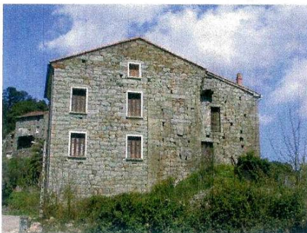
Grosseto Prugna- Les chaînes d'angle de la construction d'origine permettent d'en lire le contour. Les parements de l'ajout présentent des pierres assemblées selon des lits quasi horizontaux composés de blocs de dimensions semblables y compris aux angles.
