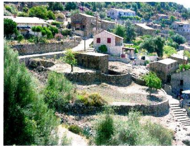
Osani - Murs de soutènement dans le hameau de Curzu.
