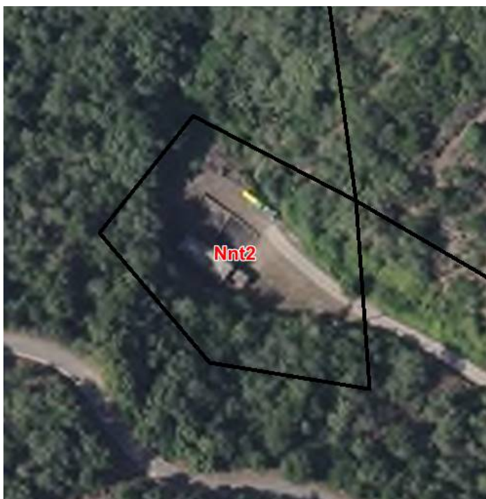
La station d'épuration est située dans les espaces remarquables.
