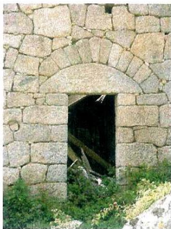
Zerubia – Détail porte- linteau avec extradós cintré et arc de décharge.
