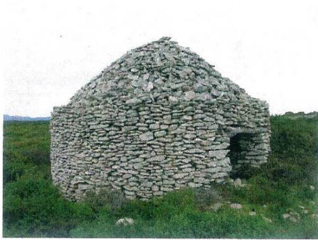
Bonifacio - Barracone ouvrage caractéristique des régions calcaires bâti selon des techniques millénaires
