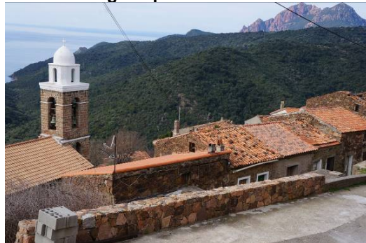
Vue sur les toits au cœur du village.
