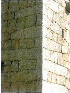
Guarguale – Ancienne maison forte – Détail d'une chaîne d'angle. Les parements montrent des pierres taillées, assemblées à joint vif, soigneusement ajustées selon leur forme. Les pierres posées à plats dont les bouts sont visibles suggèrent l'épaisseur des murs. La mise en œuvre exprime la solidité de la construction en rapport avec sa fonction.
