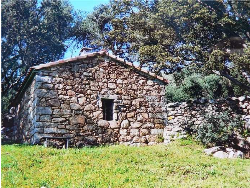
Figure 33 : Bergerie rénovée sur les hauteurs d'Olmeto
