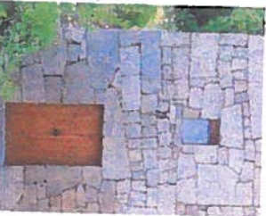
Appareil polygonal Les blocs sont de grosseurs variables et de formes irrégulières. Les pierres sont taillées et assemblées à joint vif.
