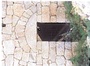
Zerubia – Détail porte- linteau avec extradors cintré et arc de décharge.
