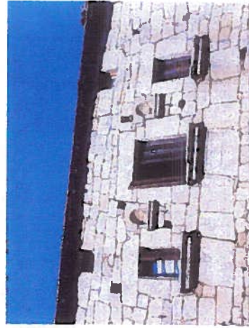
Forciolo – Détail des fenêtres de l'étage noble. Les appuis monolithes sont sculptés. Les pierres des allèges posées de champ présentent des faces approximativement carrées.
