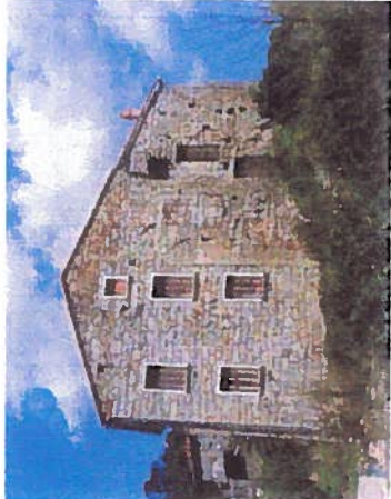
Grosseto Prugna- Les chaînes d'angle de la construction d'origine permettent d'en lire le contour. Les parements de l'ajout présentent des pierres assemblées selon des lits quasi horizontaux composés de blocs de dimensions semblables y compris aux angles.
