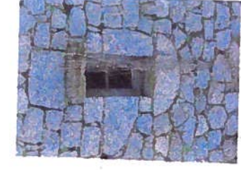
Appareil irrégulier Les blocs sont de formes irrégulières, grossièrement taillés, posés en laissant entre eux des interstices remplis par des cailloux.
