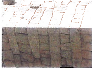
Guarguagole – Ancienne maison forte – Détail d'une chaîne d'angle. Les parements montrent des pierres taillées, assemblées à joint vif, soigneusement ajustées selon leur forme. Les pierres posées à plats dont les bouts sont visibles suggèrent l'épaisseur des murs. La mise en œuvre exprime la solidité de la construction en rapport avec sa fonction.
