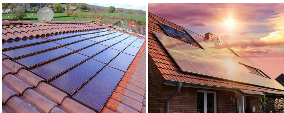
Exemple de panneaux solaires intégrés par rapport à la pente de la toiture et de la couleur demandée
