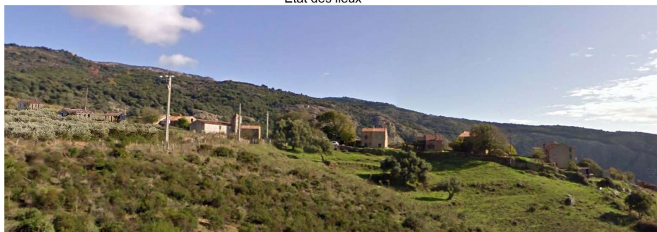
Insertion de nouvelles constructions
