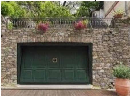
Exemple de toiture terrasse d'un volume enterré
