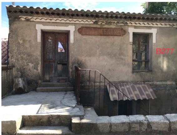
22 – Pierre sculptée 40 – linteau pierre 41-ensemble façade
