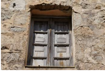
Volets intérieurs à conserver et réhabiliter à l'identique
