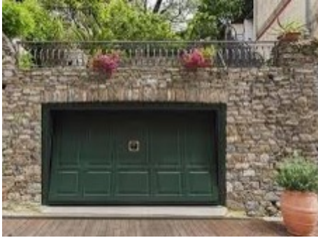
Exemple de toiture terrasse d'un volume enterré
