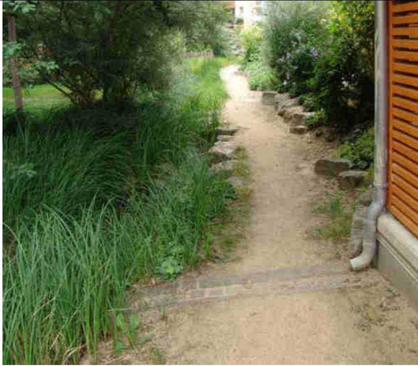
Canalisation de l'eau de pluie via une rigole en pavés à travers du chemin
