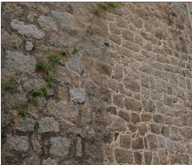
maçonnerie de bloc de granit grossièrement équarris
