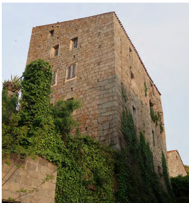
vue depuis le sud-est
