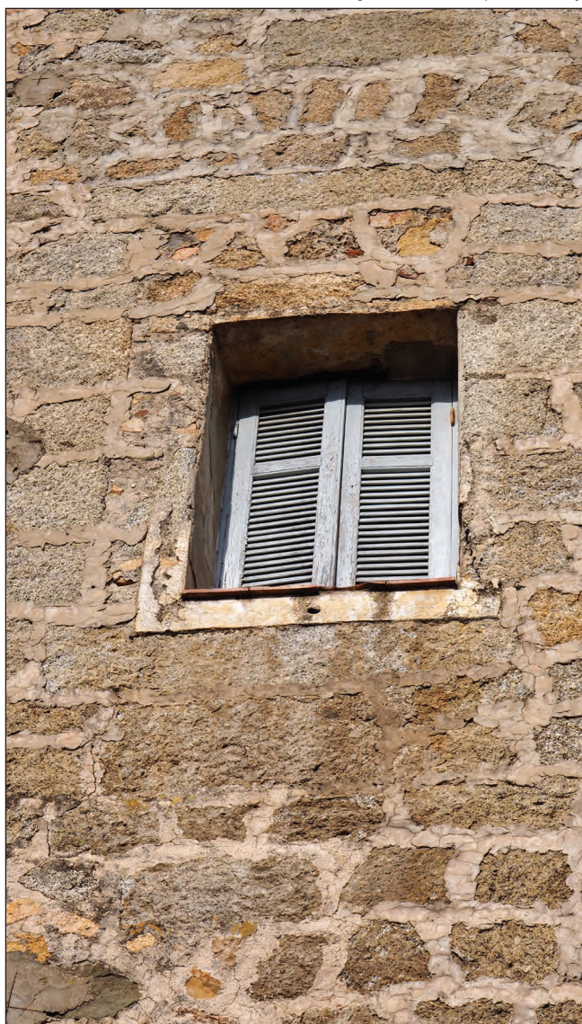
enduit à pierres vues et mortier de ciment
