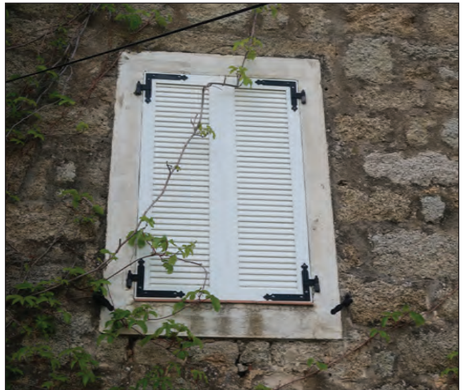
volet en bois avec pentures extérieures
