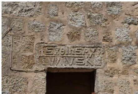
Détails en façade
