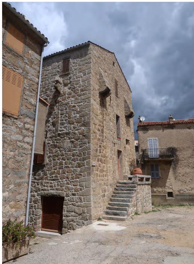
vue depuis le sud-est
