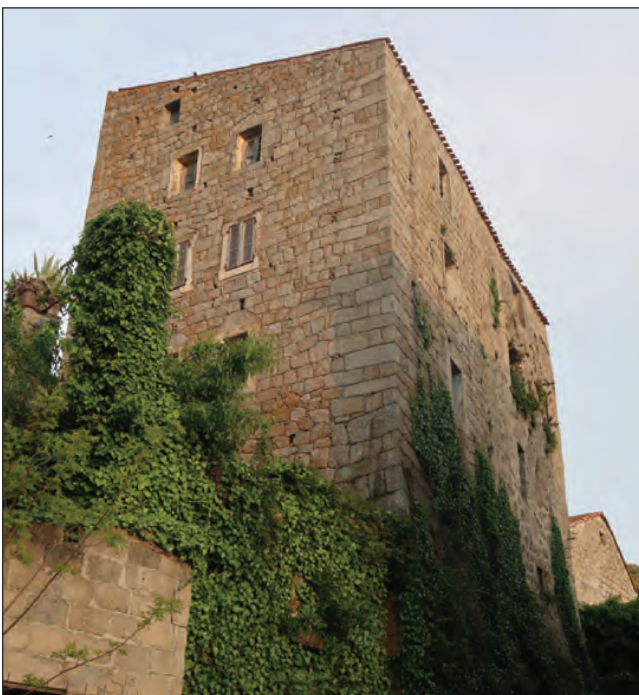
vue depuis le sud-est
