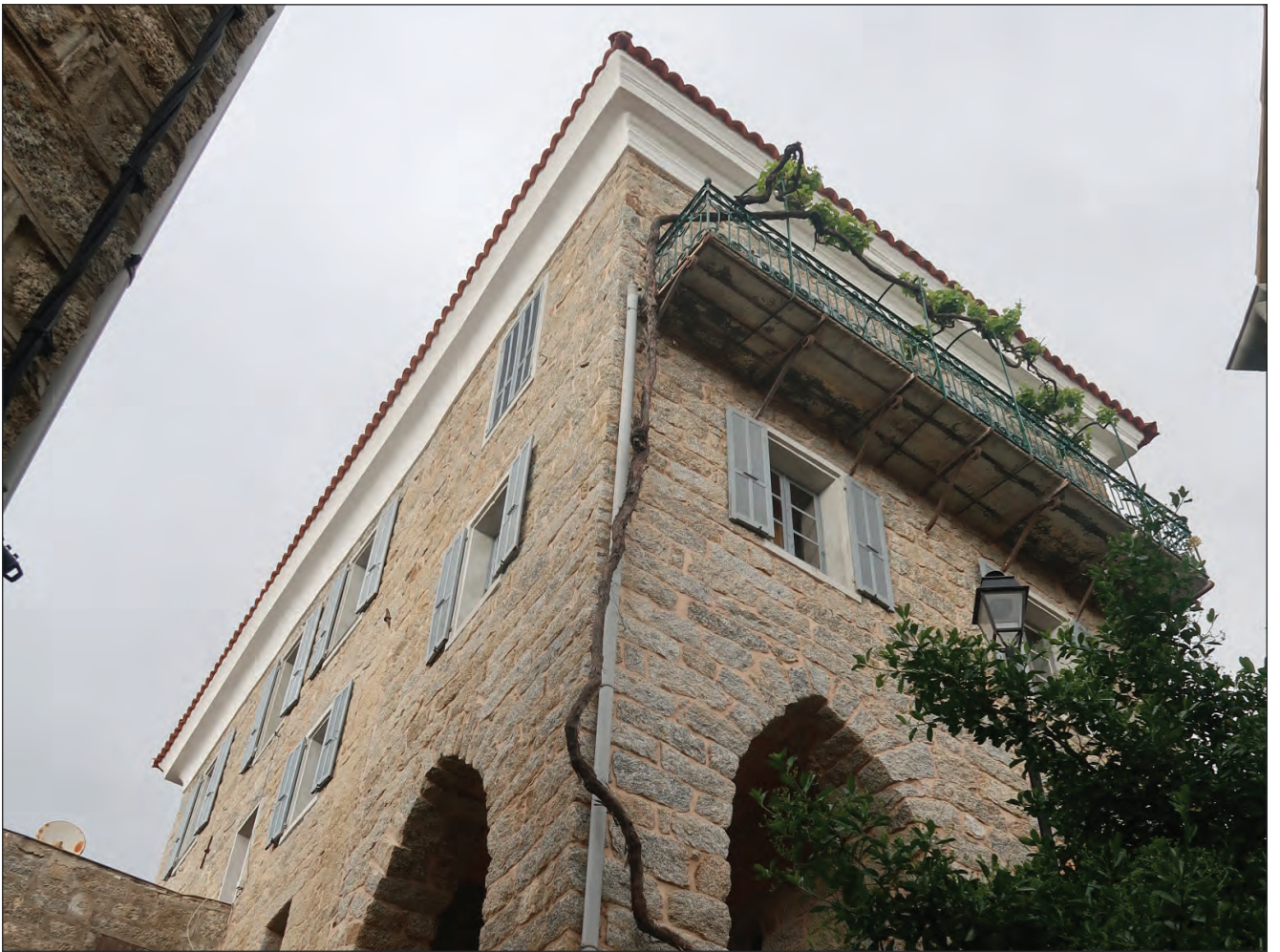
vue sur façade principale
