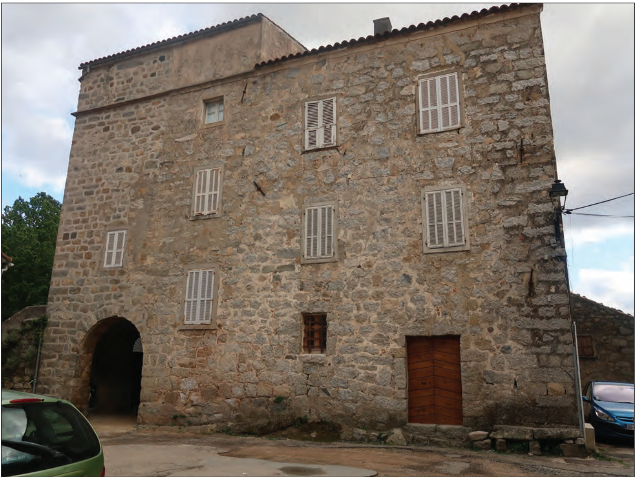
vue sur façade nord-est
