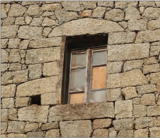
Baie sur façade ouest
