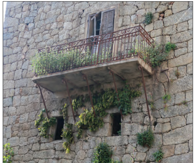
Balcon sur façade est
