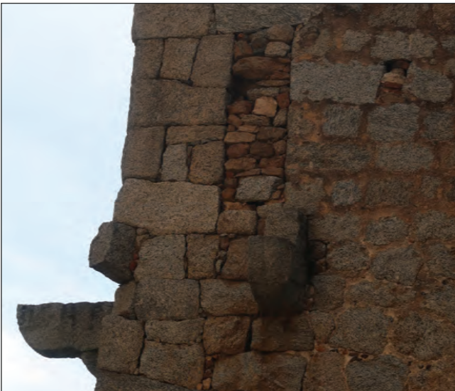
Support de hourd et ouverture bouchée
