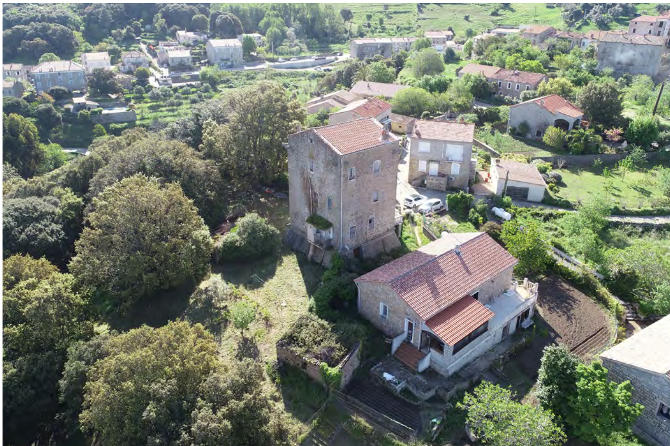
vue depuis l'ouest
