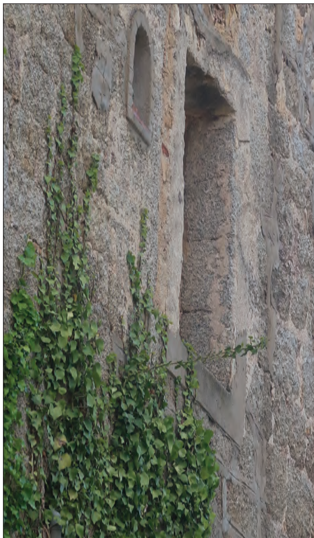
niche et baie sur façade
