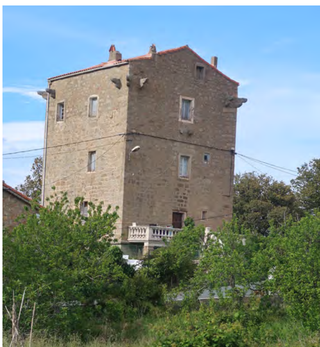
vue depuis le sud
