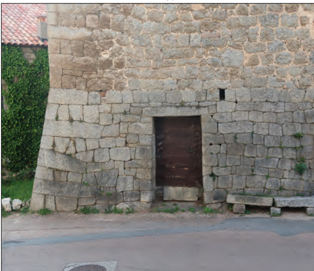
Soubassement taluté et entrée
