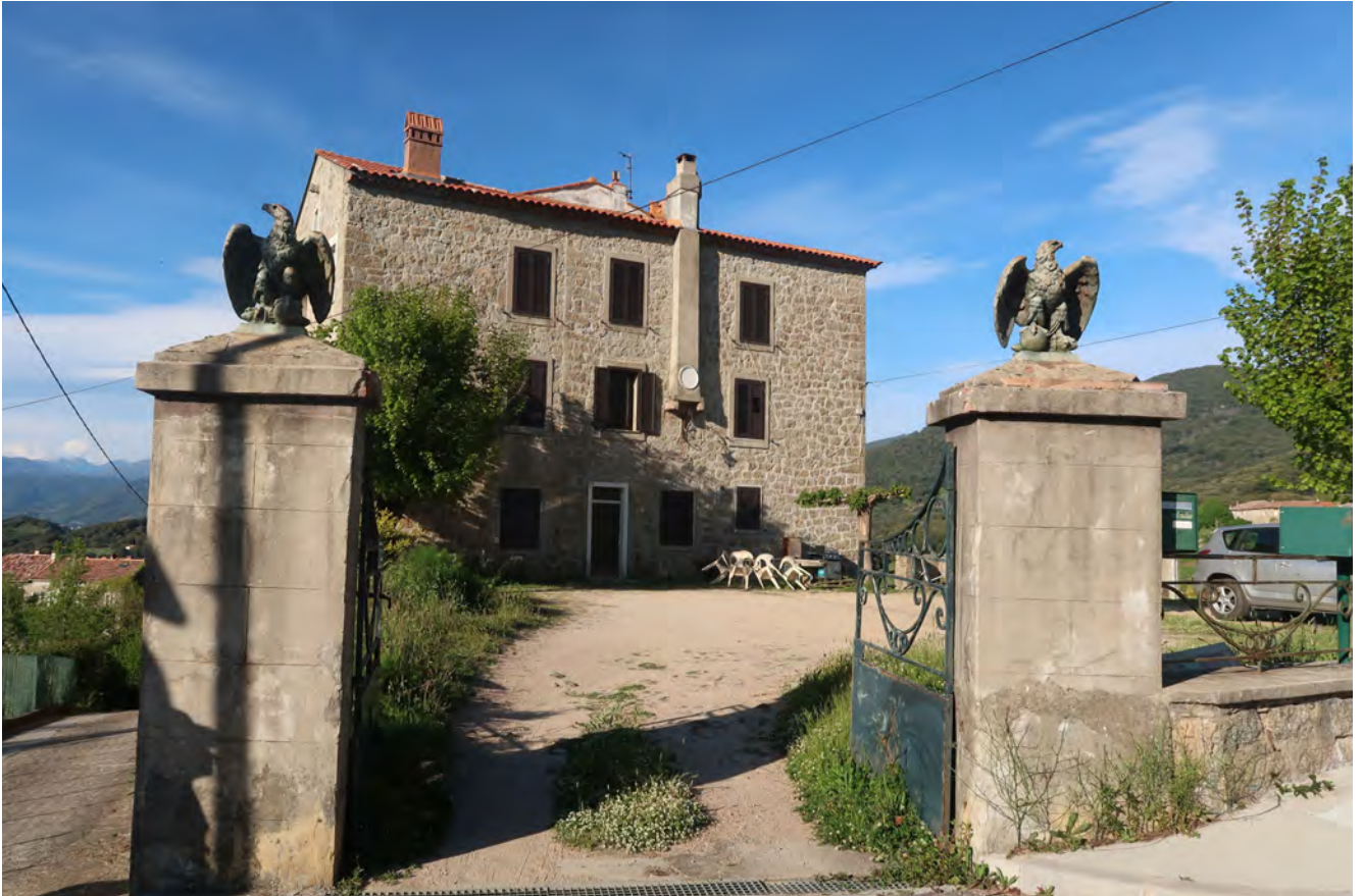
vue depuis l'ouest
