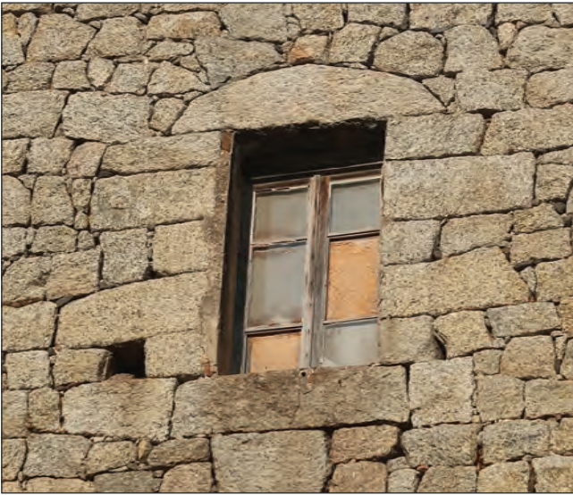
Baie sur façade ouest
