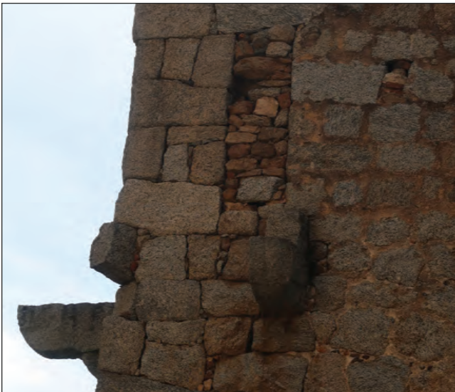
Support de hourd et ouverture bouchée
