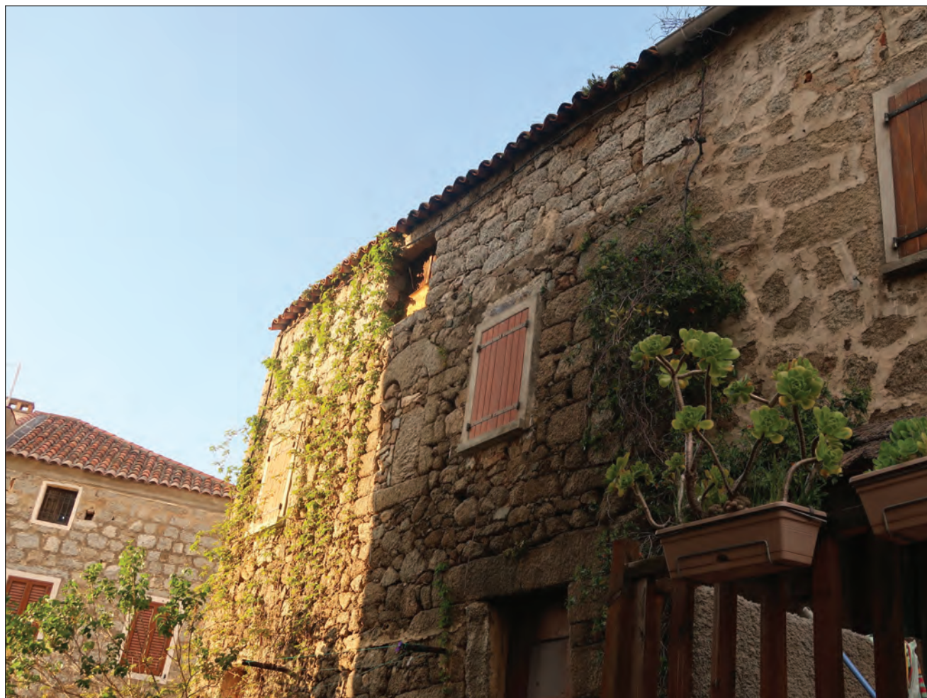
vue sur façade principale
