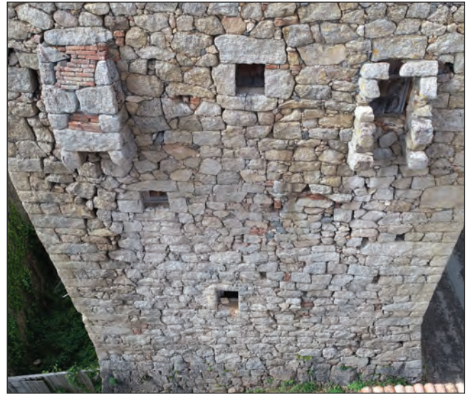
détail façade nord
