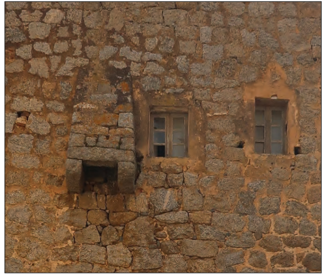
bretèche sur façade est
