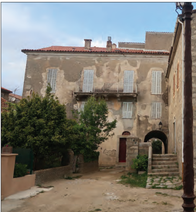
vue sur façade sud-ouest
