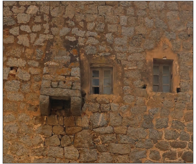
bretèche sur façade est
