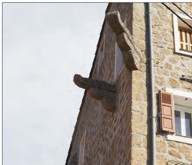
Consoles d'angle sur façade Sud
