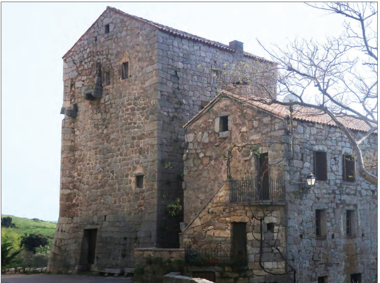
vue sur façade principale
