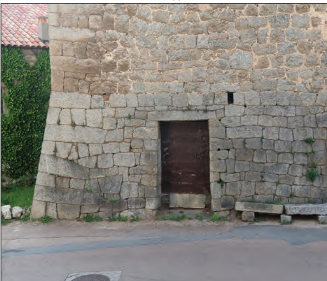
Soubassement taluté et entrée
