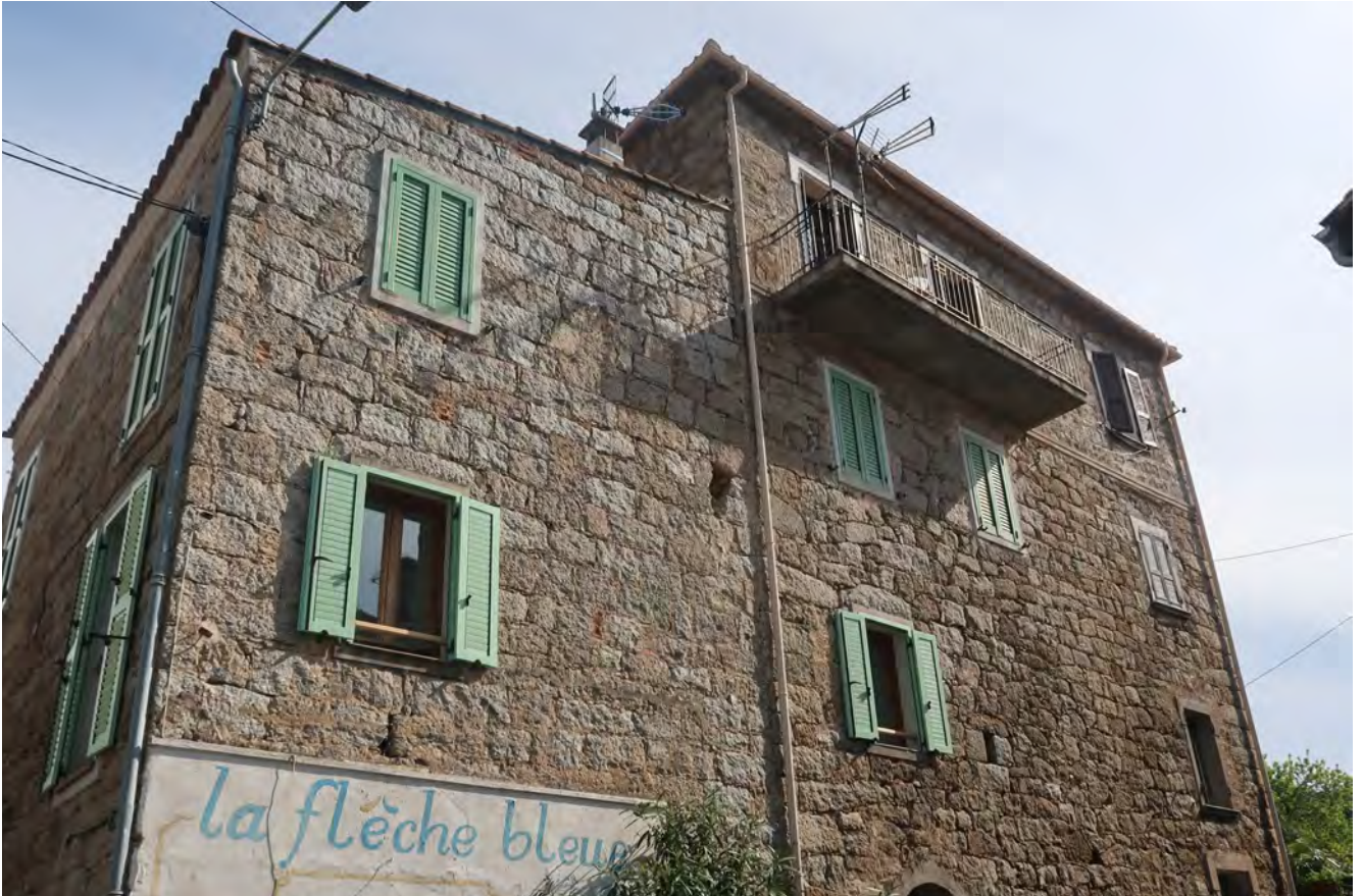
vue sur la façade principale
