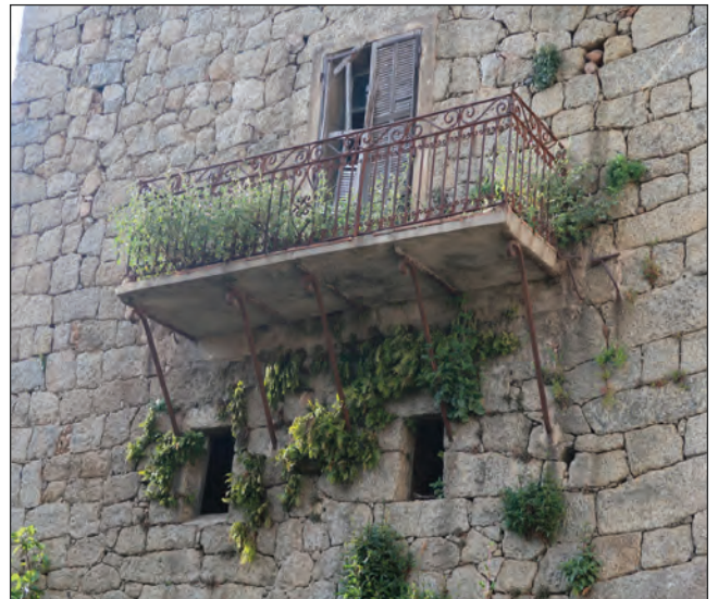
Balcon sur façade est
