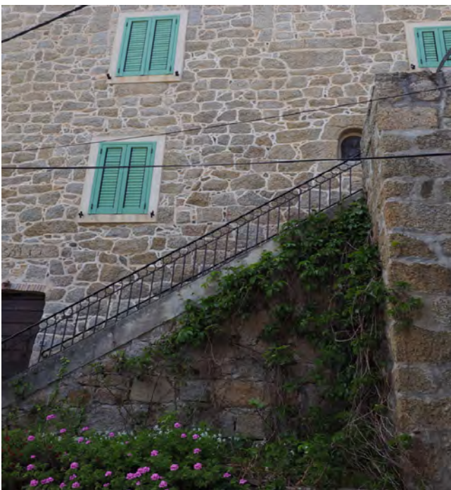
escalier sur façade est
