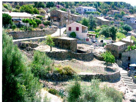
Osani - Murs de soutènement dans le hameau de Curzu.
