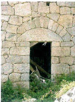
Zerubia – Détail porte- linteau avec extradors cintré et arc de décharge.
