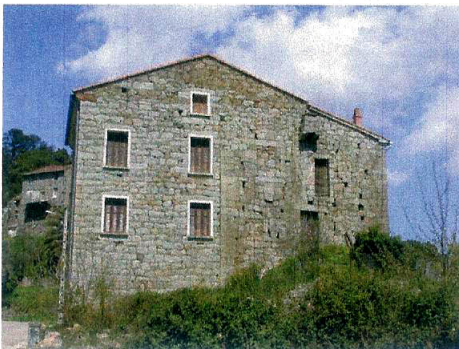
Grosseto Prugna- Les chaînes d'angle de la construction d'origine permettent d'en lire le contour. Les parements de l'ajout présentent des pierres assemblées selon des lits quasi horizontaux composés de blocs de dimensions semblables y compris aux angles.
