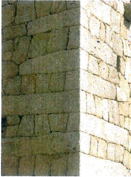
Guarguale – Ancienne maison forte – Détail d'une chaîne d'angle. Les parements montrent des pierres taillées, assemblées à joint vif, soigneusement ajustées selon leur forme. Les pierres posées à plats dont les bouts sont visibles suggèrent l'épaisseur des murs. La mise en œuvre exprime la solidité de la construction en rapport avec sa fonction.
