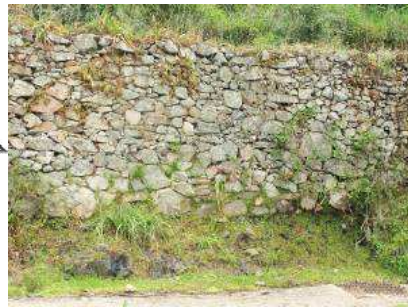
Exemple de murs de soutènement
