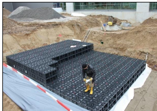
Figure 14 : Vue de la mise en place d'un bassin enterré à structure alvéolaire
