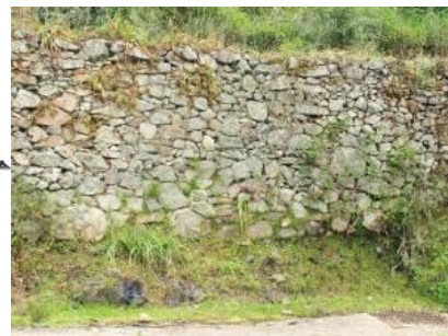
Exemple de murs de soutènement
