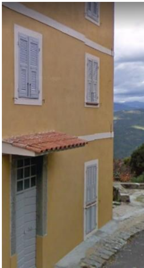
Exemple de facade enduite
