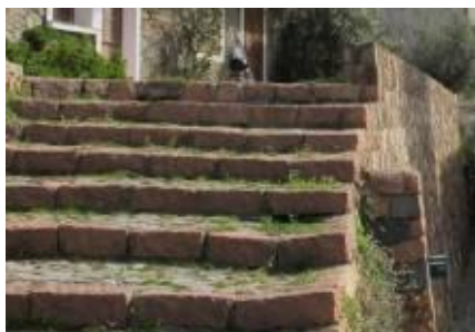
Exemple d'escaliers en pierres locales
