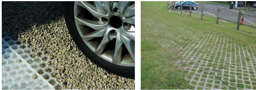
Exemples de revêtements perméables et carrossables
