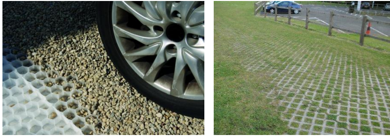
Exemples de revêtements perméables et carrossables
