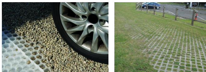
Exemples de revêtements perméables et carrossables
