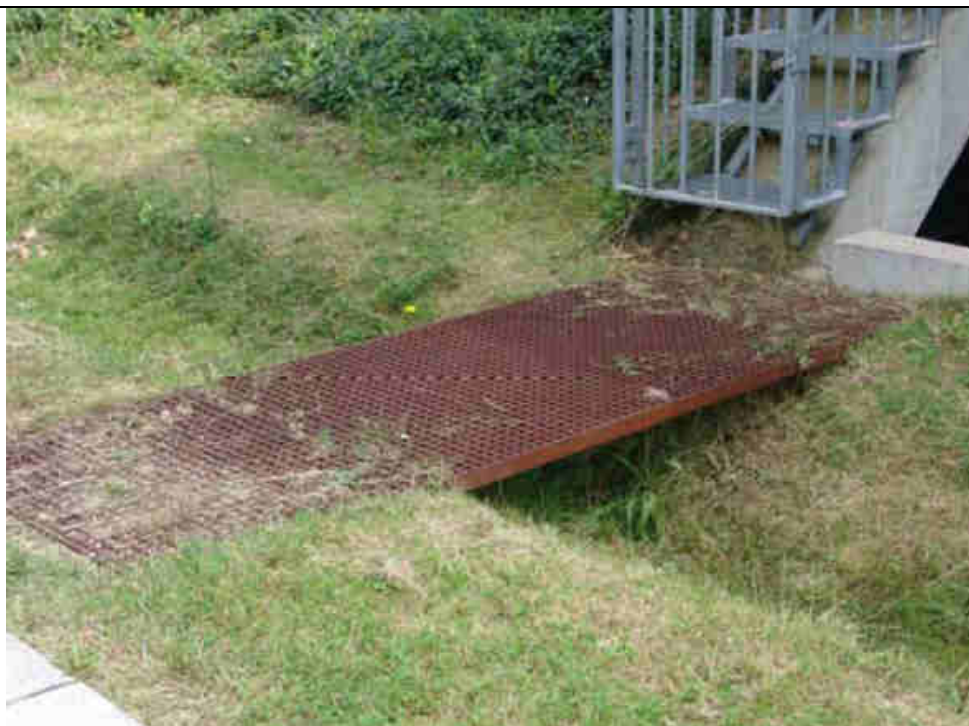
Enjambement d'un petit fossé longeant un trottoir au pied d'une sortie de secours d'en bâtiment public
