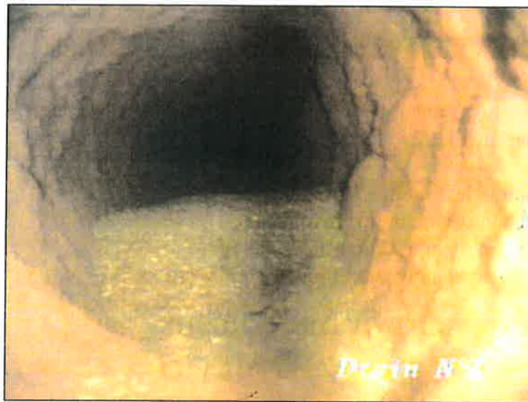
Fig. 7 – Photo tronçon 4 – colmatage et remplissage de sable
