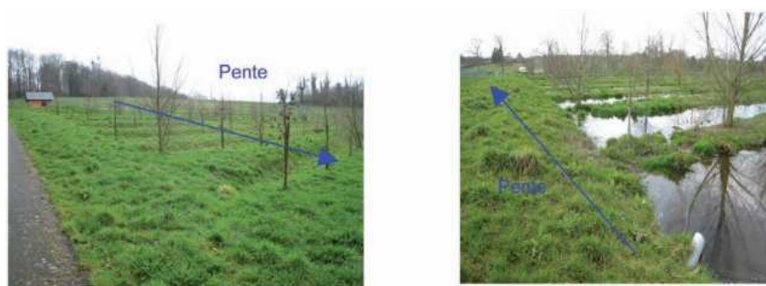
Photo 2 : Aire d'infiltration des STEP de Saint Germain les Essourts et Sainte Croix sur Buchy
