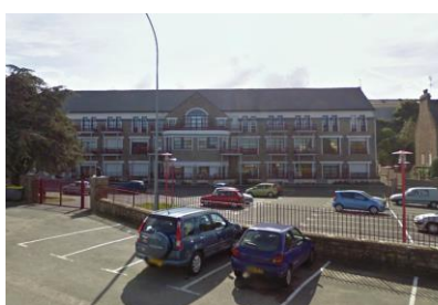
Un exemple de bâtiment réhabilité
