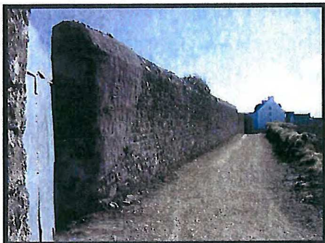
vue d'un des accès au secteur, longé par un haut talus-mur
