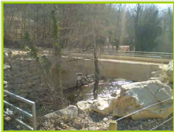
Fig. 1 : Vue de profil de la passerelle prise au nord est de cette dernière (Photo : Mickaël Monvoisin)
