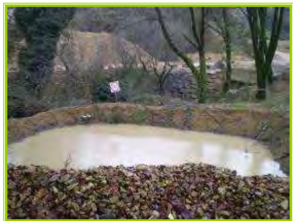
Fig. 6 : Bassin actuel de décantation des eaux d'exhaure du site sud de la carrière (Photo : Mickaël Monvoisin)
