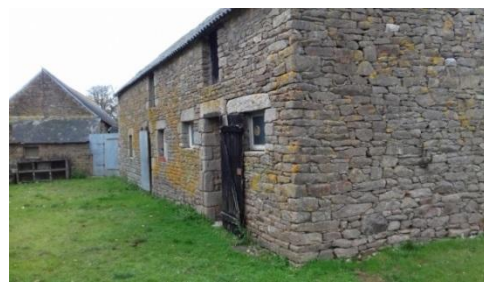
Bâtiment 14 à gauche, bâtiment 7
