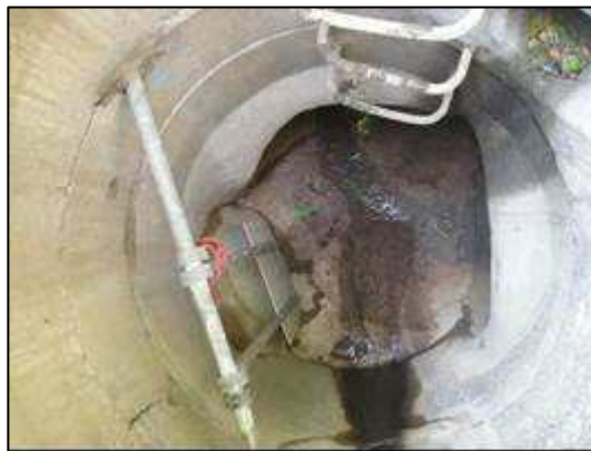
Photo 2 : Clapet anti retour
