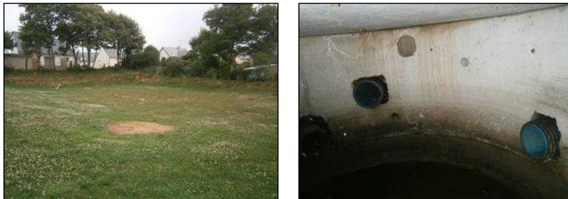
Figure 41 : Bassin d'infiltration de Kervinouel
