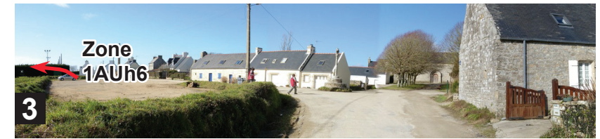
3 En bordure d'un espace public fédérateur : place devant la chapelle, charnière avec le stade
