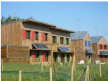
Habitat individuel groupé Langouët, Brégent Cornillet architectes
