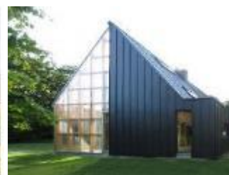
Extension d'une habitation Saint Thonan, Yannick Jegado
