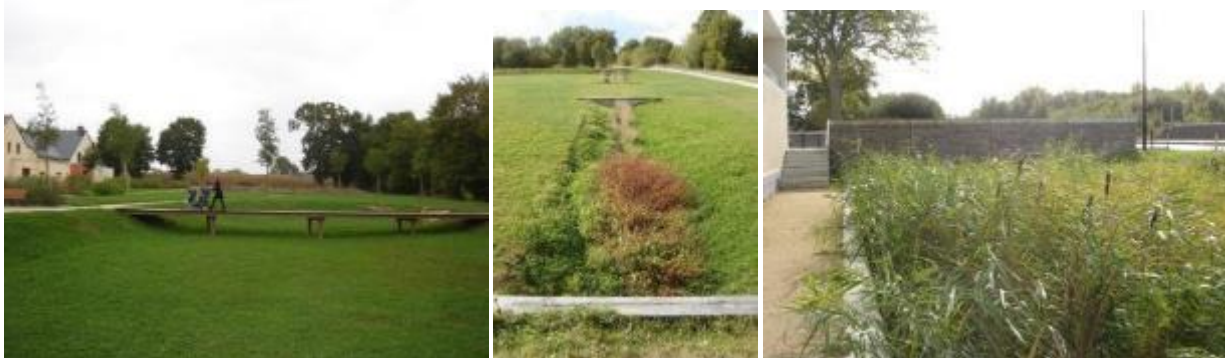
Exemple de bassins paysagés et noues plantées
