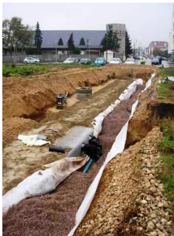
Remblaiement de la structure
