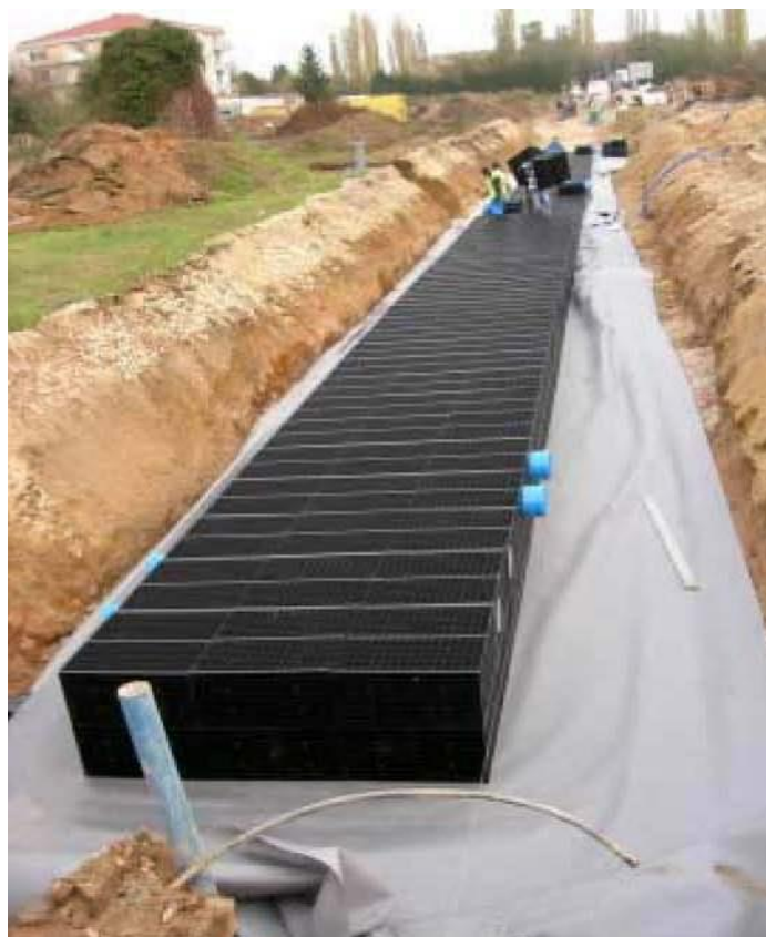
Mise en place des casiers sur géomembrane puis géotextile
