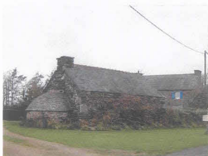
Un ancien four à pain
