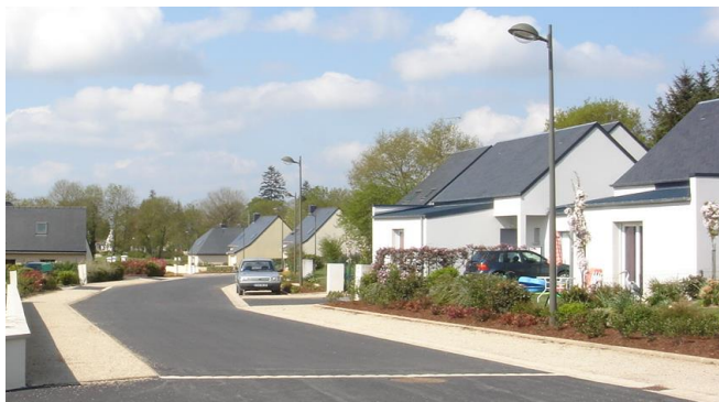
Rue de taille adaptée desservant plusieurs lots, avec une utilisation mesurée de l'enrobé
