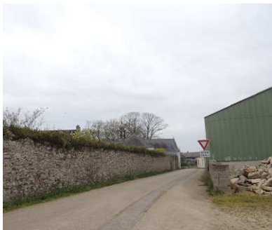
Clôture en mur maçonné ancien
