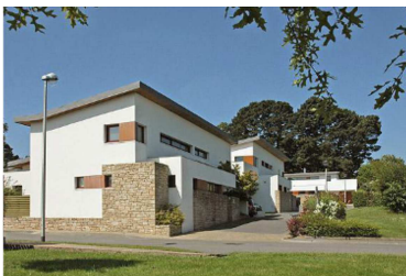
Habitat individuel Vannes, ARCAU architecte
