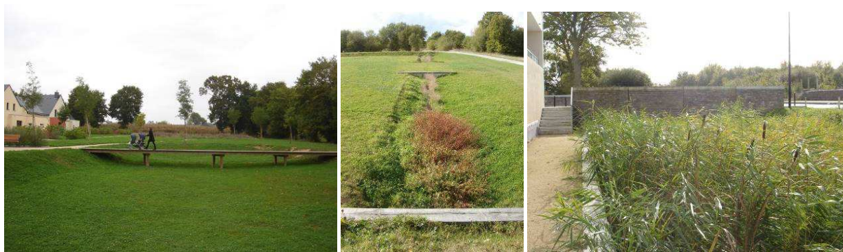
Exemple de bassins paysagés et noues plantées
