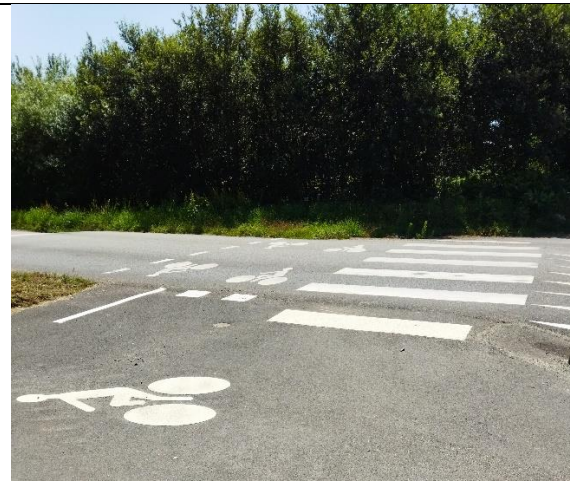
Piste cyclable et passage piéton pour traverser la Streat an Arvoriz
