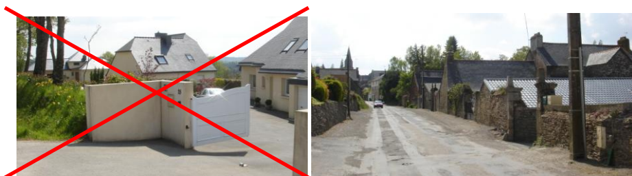
Une transition difficile entre un talus boisé et un mur de clôture et les murets en pierres
