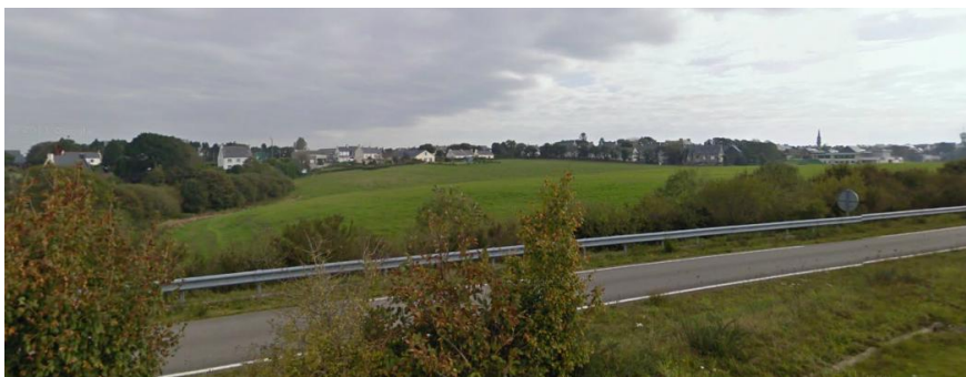
Vue de la zone 1AUBb à partir de la RD 765 (direction Douarnenez/ Quimper) avant terrassement
