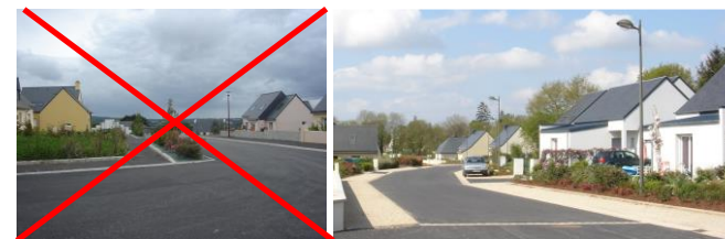
Exemple d'utilisation abusive de l'enrobé et d'une rue de taille adaptée desservant plusieurs lots, avec une utilisation mesurée de l'enrobé
