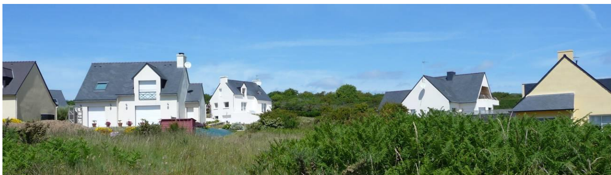
Exemple de lotissement pavillonnaire individuel récent au Loc'h
