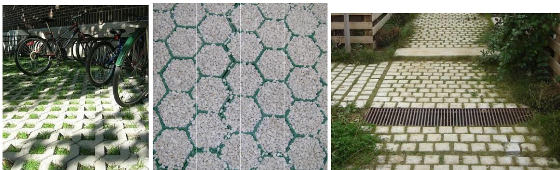
Exemple de matériaux perméables : dalle béton enherbée, gravillons, pavés non jointoyés (source : AUDIAR)
