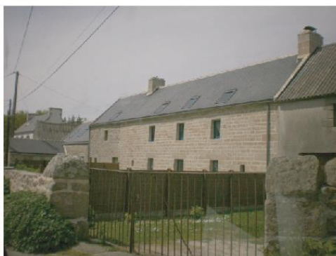
Ancien bâti rénové à Kervergar
