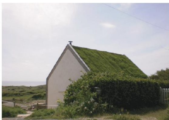
Bâti avec toit végétal
