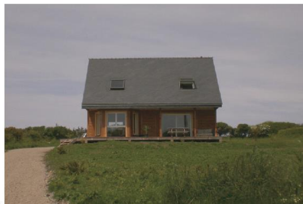
Construction en bois
