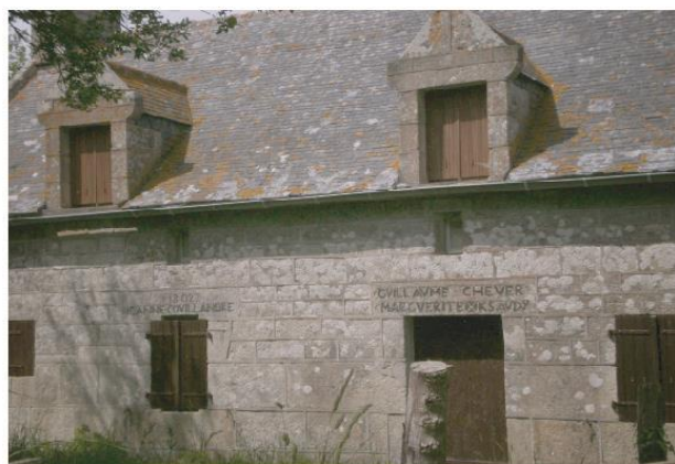
Bâti ancien à Kergouneau
