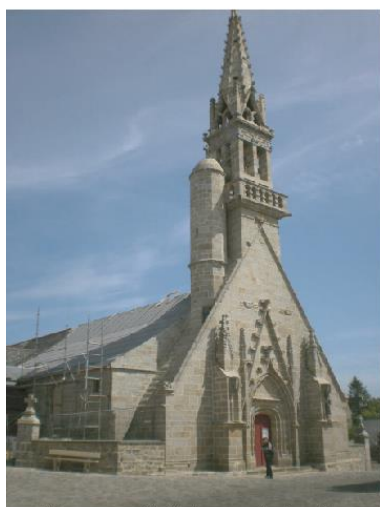
Eglise paroissiale Saint Fiacre Saint Collodan
